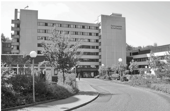
Spitäler Schaffhausen, Haupteingang
