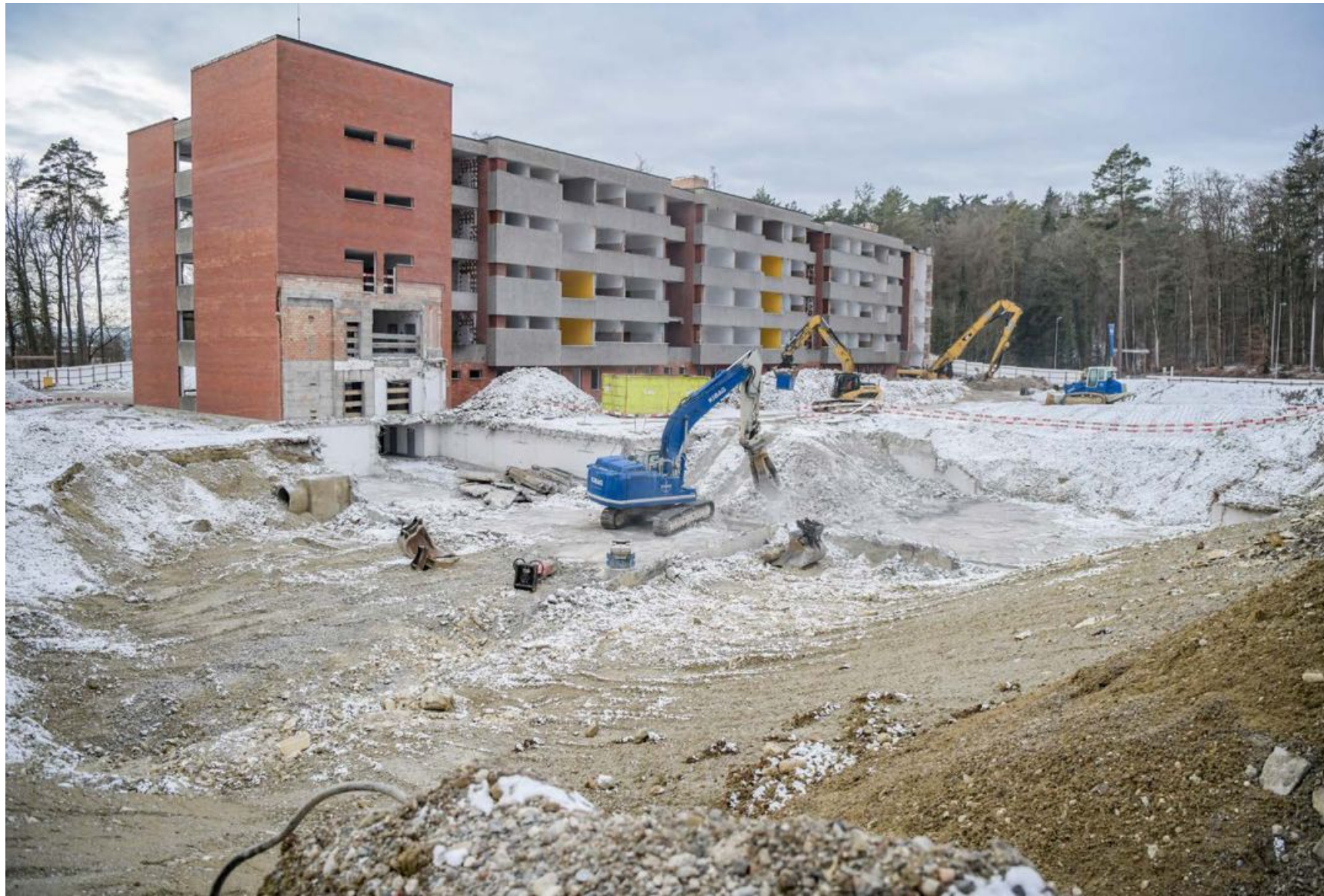
Noch steht der ehemalige Bettentrakt, bis Ende Jahr soll aber alles verschwunden sein.
