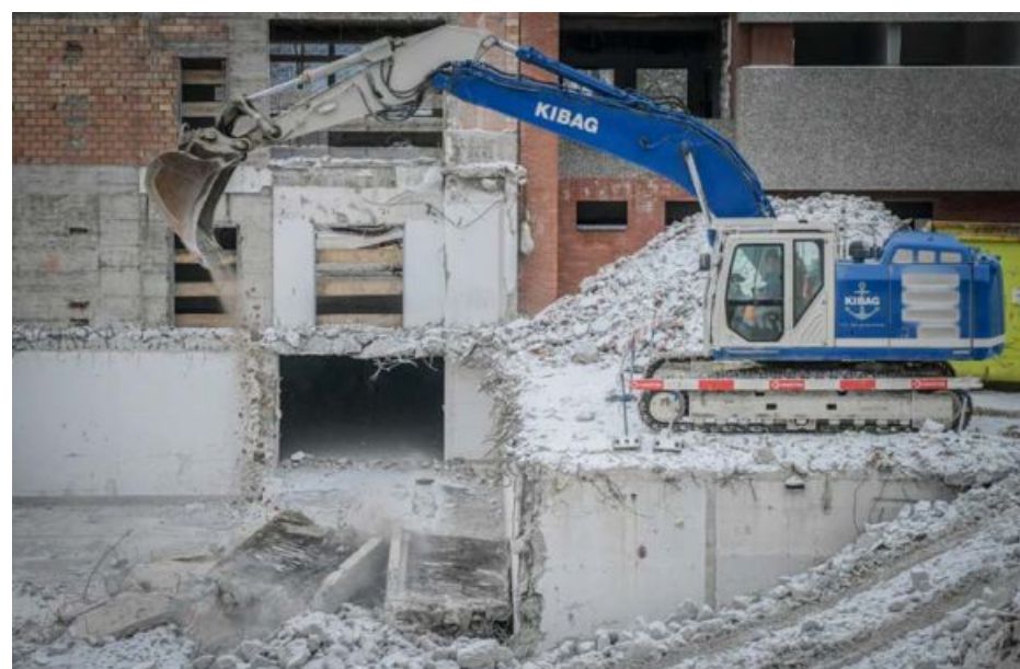
Die vom Bagger zerbrochene Betonplatte wog circa 4,5 Tonnen.
