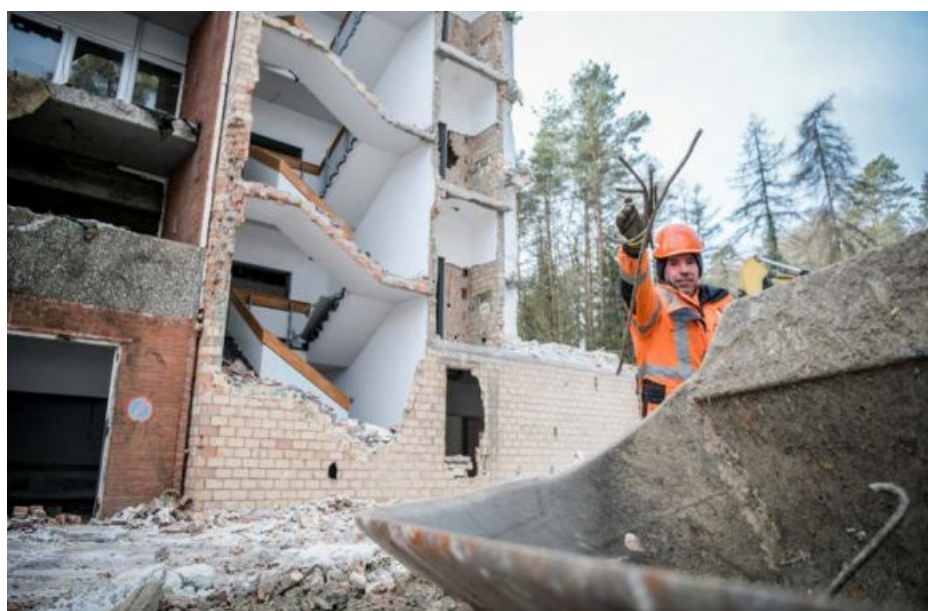
Handarbeit: Die Angestellten holen Eisenreste auch von Hand aus dem Abbruch.
